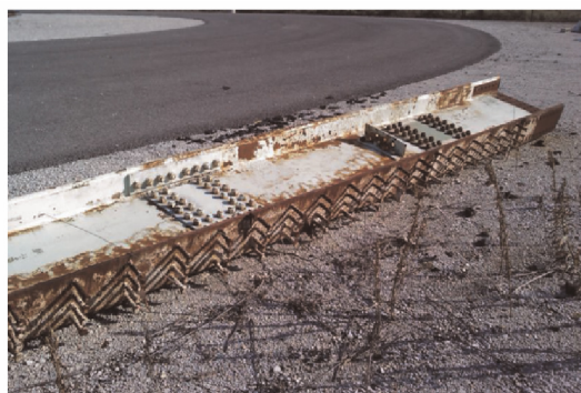
图2 使用30年的钢-混组合梁
