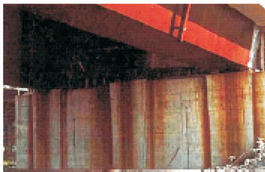
图 24 未形成稳定锈层导致锈液流淌到墩台上
