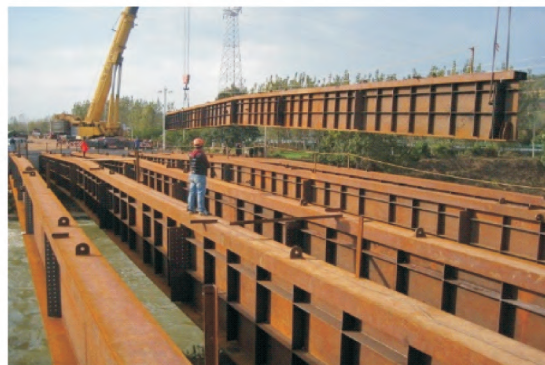
图20 钢梁整体吊装
