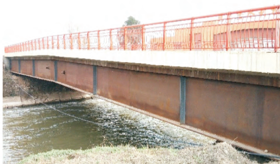
图19 眉县常兴二号桥
