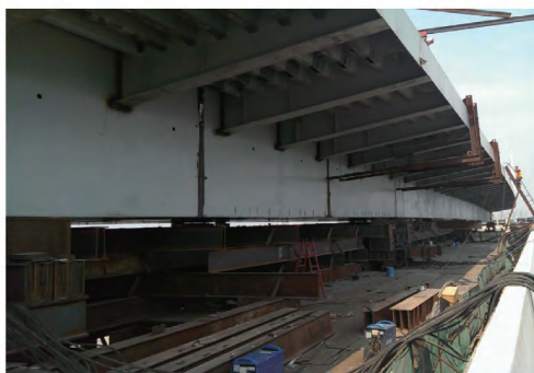
(a) 钢箱梁外侧涂装
