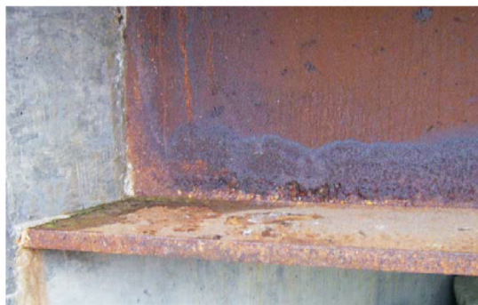
图 23 排水措施不合理导致钢梁与混凝土桥台结合处局部锈蚀
