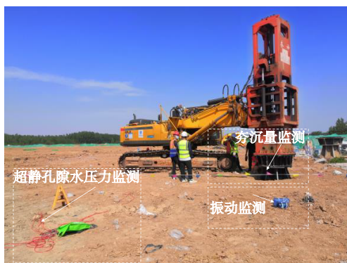
图4 夯沉量、孔隙水压力及地面振动监测
